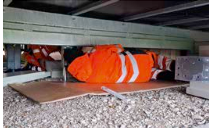
Unter dem Wichtelwagen des Waldkindergartens wurde die Wasserleitung isoliert
