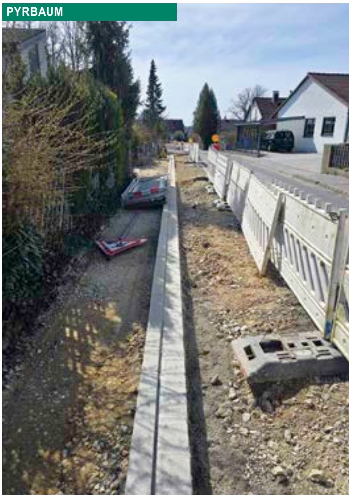
Erneuerung der Wasserleitung und des Gehwegs in der Tannenstraße
