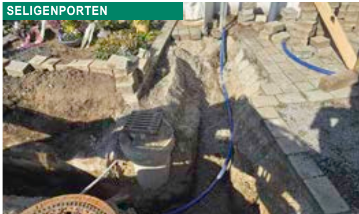
Friedhof: Umverlegung der Wasserleitung
