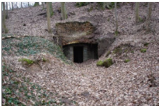
Eingang ehemaliger Feihl-Keller in Pyrbaum am Sportplatz
